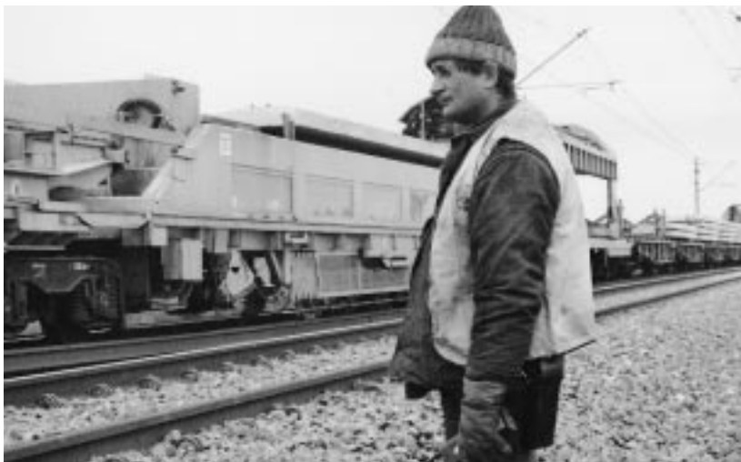
Pologne: 2,5 kilomètres de voies ferrées par jour ont pu être posées grâce au train de pose automatisé suisse.
