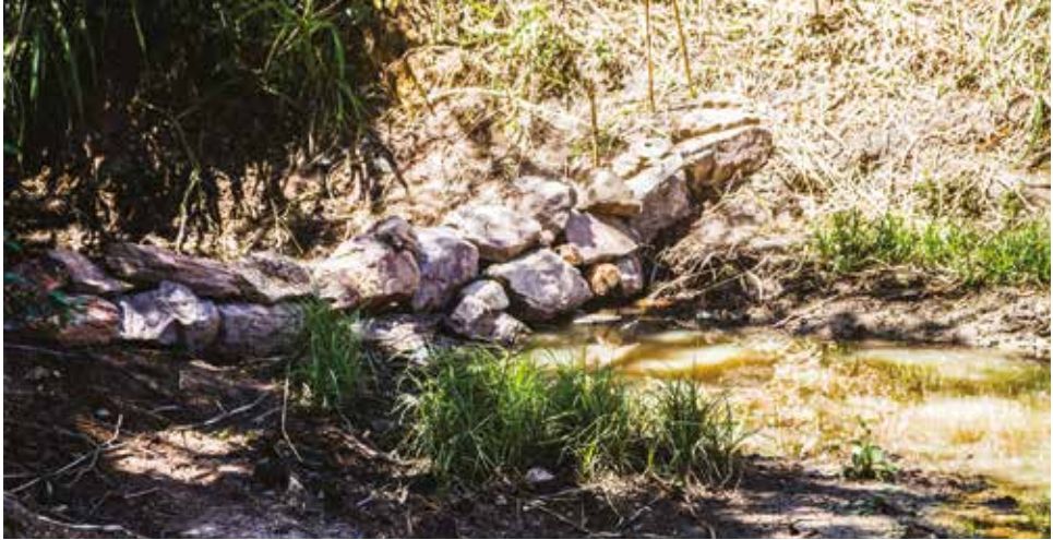
Los muros de piedra o barreras muertas actúan como disipadores de energía, reduciendo la velocidad de la esorrentía que ingresa directamente al reservorio. Foto: CATIE.
