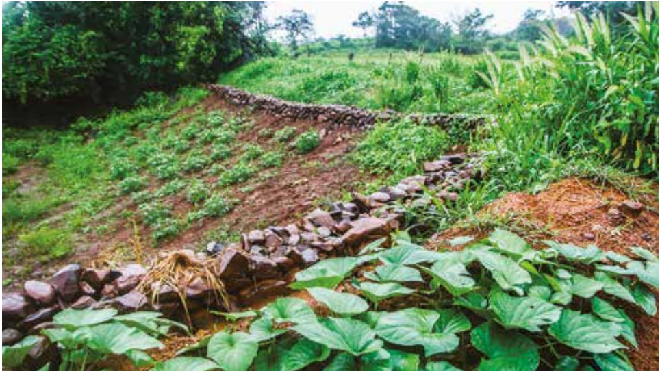
Muro de piedra con protección de barrera muerta de tierra compactada. Foto: CATIE.
