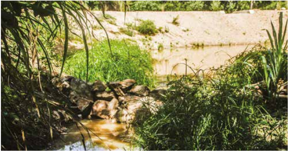
Dique de piedra para reducir velocidad de la escorrentía y “colar” los sedimentos. Foto: CATIE.
