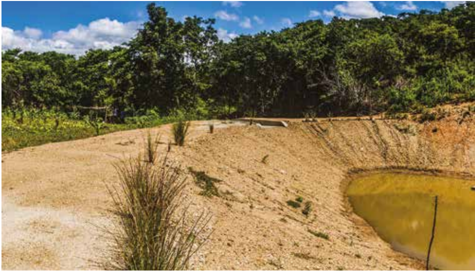
El lodo arcilloso debe usarse con frecuencia para curar fisuras en los taludes internos del reservorio. Foto: CATIE.
