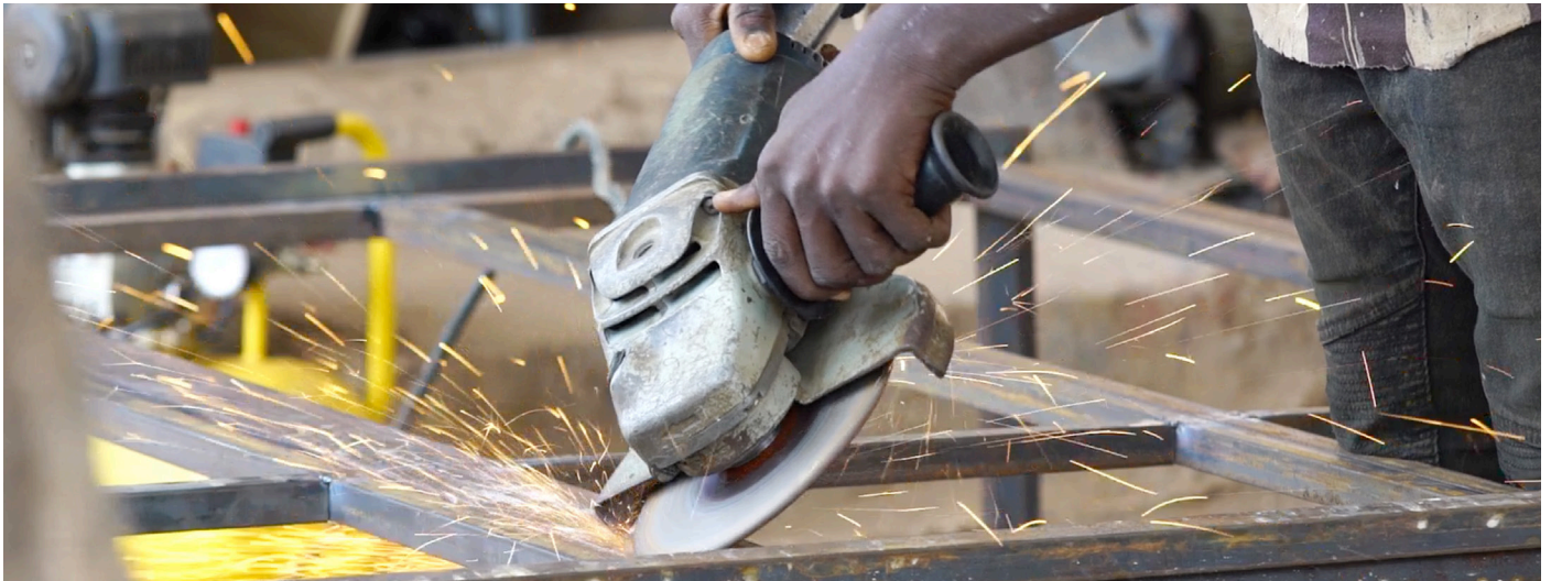
Bénéficiaire de formation en construction métallique dans le cadre du FCSE à travers le FAFPA dans la région de Dosso
