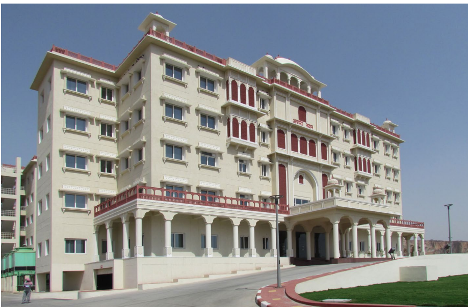
Le bâtiment construit pour le Service des forêts de l'État du Rajasthan à Jaipur peut servir de modèle. Sa consommation d'énergie est inférieure de moitié au label «cinq étoiles» développé par le Bureau indien pour l'efficacité énergétique. © BEEP
