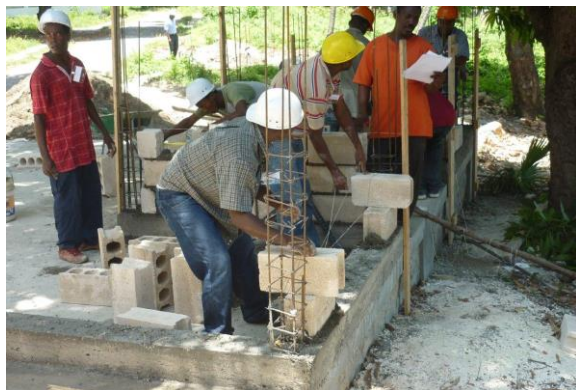
Maçons pendant la formation sur chantier. © DEZA
