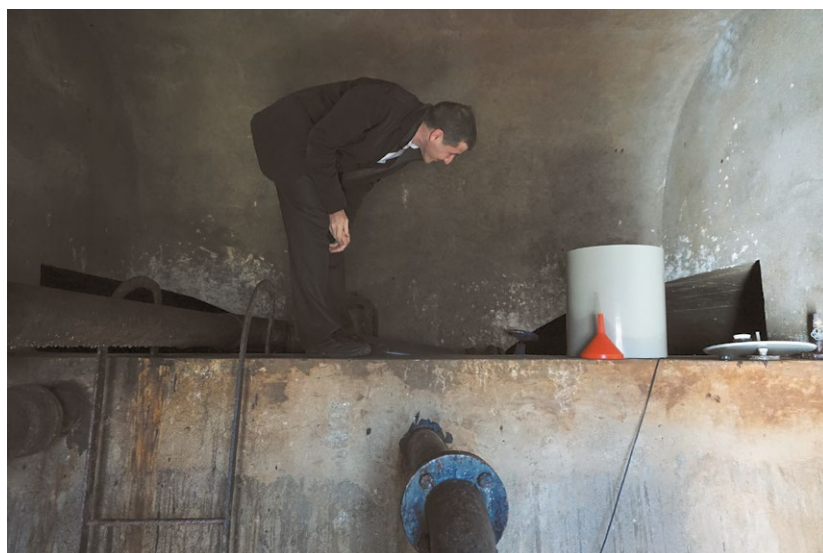
Ein Schweizer Experte besichtigt in der kroatischen Gemeinde Fužine das bestehende Trinkwasserreservoir, das 1960 erbaut wurde. © SECO
