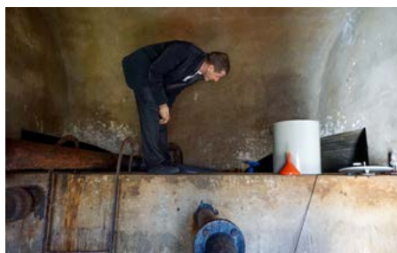
Dans la commune croate de Fužine, un expert suisse inspecte le réservoir d'eau potable datant de 1960. © SECO
