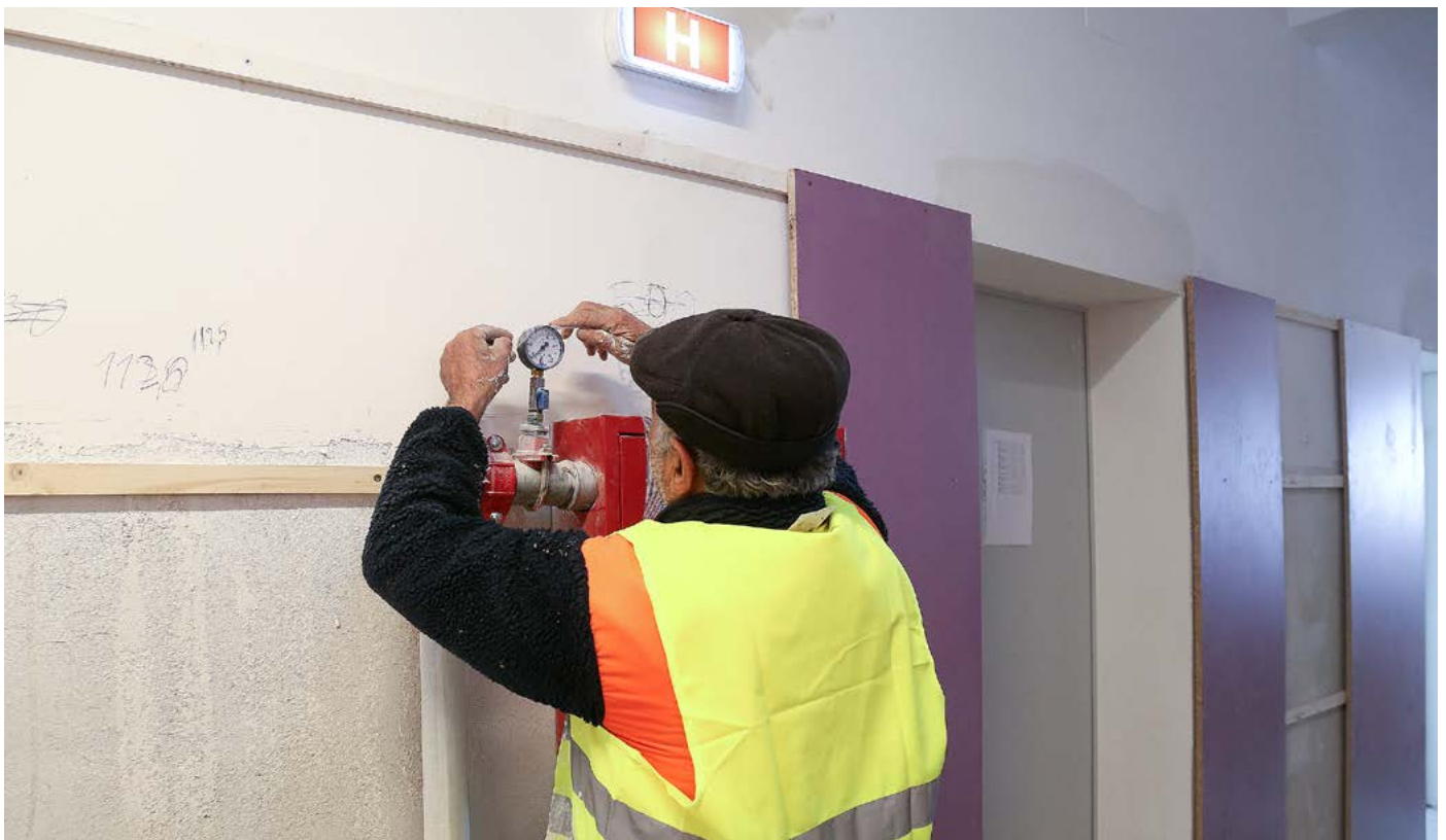
La Suisse aide plusieurs villes roumaines à développer et à mettre en œuvre des stratégies énergétiques durables. Les villes de Brasov et de Cluj-Napoca ont décidé de procéder à l'assainissement énergétique de 4 écoles. © SECO
